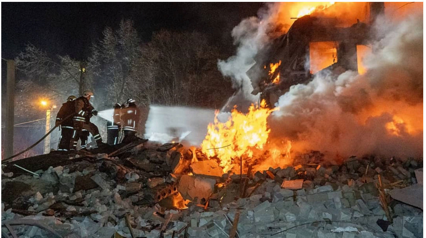
Des pompiers luttent contre l'incendie d'un immeuble touché par une frappe russe, Kyïv, septembre 2026.
